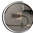
eingefräste Kabelführung
